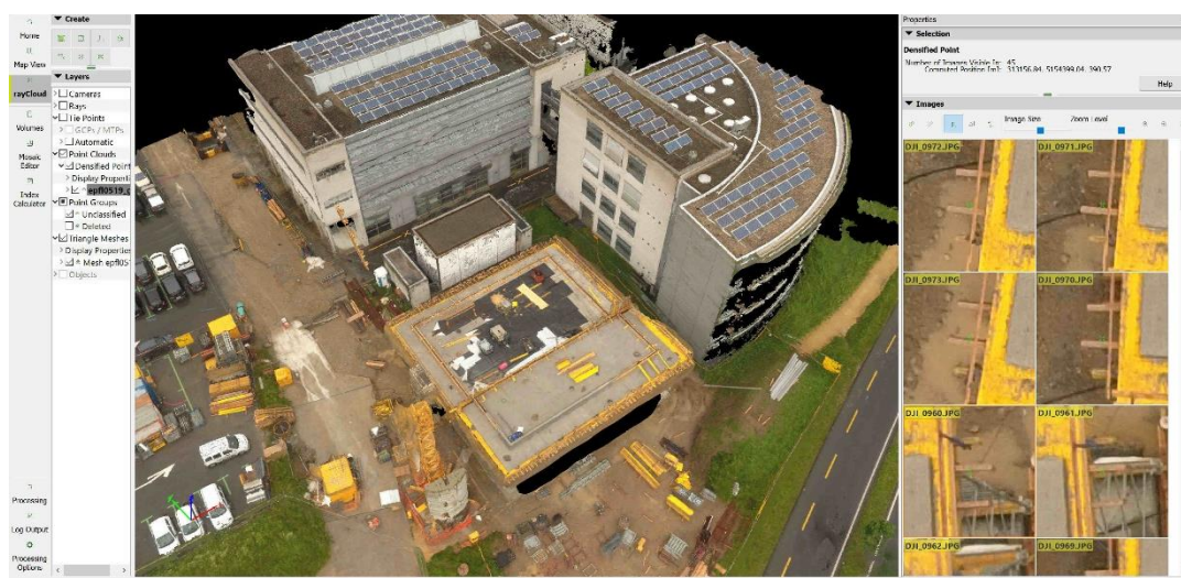
Figure 42. Suivi de chantier par une campagne de numérisation étalée dans le temps (relevé par drone) avec possibilité de comparaison à la maquette BIM d'exécution. Source : Pix4D
