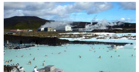
Geothermiecentrale Amp Lagoon, IJsland (bron: www.oryktosploutos.net )
