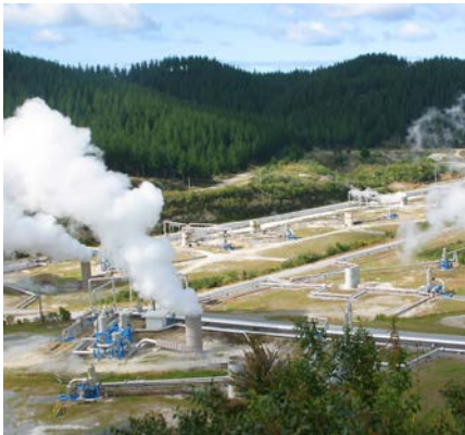
Geothermiecentrale Kamojang, Indonesië (bron: http://kupasiana.psikologiup45.com/2013/11/pembangkit-listrik-
