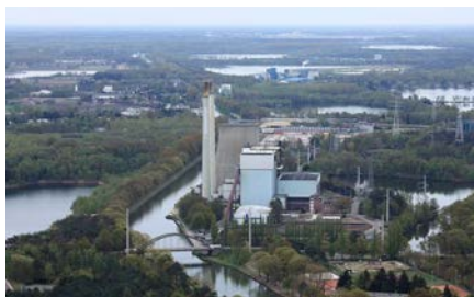
De voormalige steenkoolcentrale tussen Boeretang en Kempisch kanaal.
