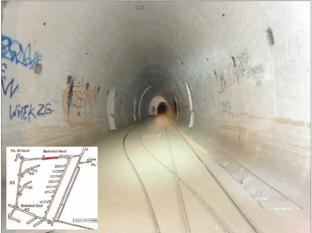
Fig. 2: Underground railway station „Bahnhof Nord“ in Boryszyńska Loop in southern part of the underground system. Abb. 2: Untergrund „Bahnhof Nord“ in der Boryszyńska Schleife im südlichen Teil des Untergrund-Systems (Foto: PETER SUCHÁNEK)
