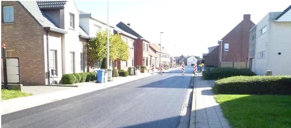
Figuur 3-2: De Zandvlietse Dorpstraat vóór de aanleg van de proefvakken. [A. Bergiers]
