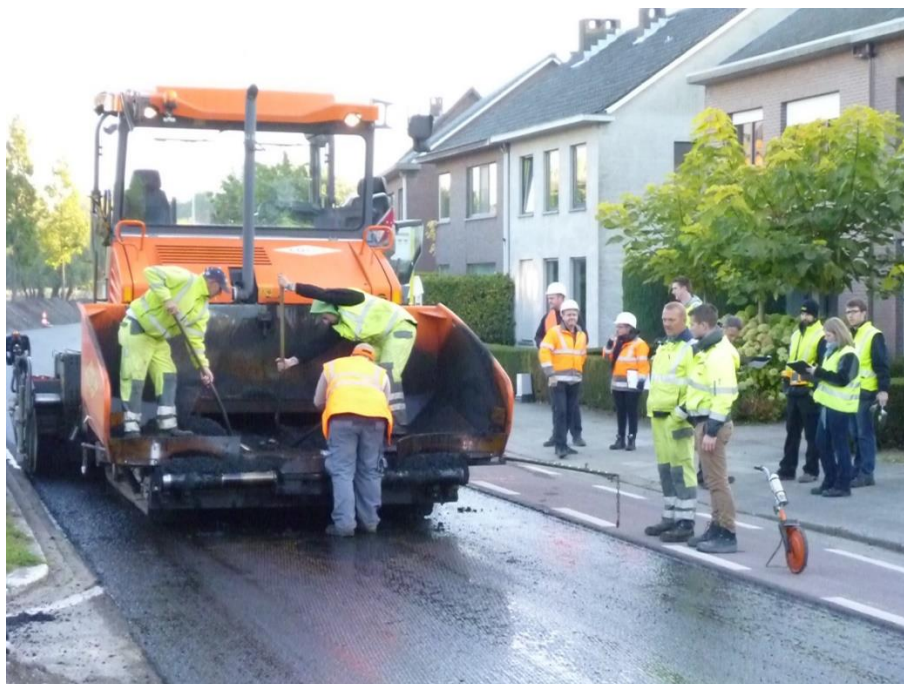
Figuur 4-2 Aanleg van het proefvak Decipave in Wilrijk door aannemer Rasenberg Wegenbouw BV [C. Vuye]
