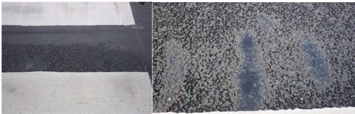
Figuur 5-1 Rafeling op het proefvak Microville [B. Duerinckx – 15]
