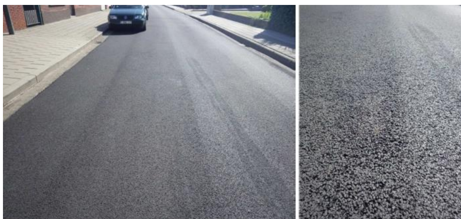
Figuur 5-10 Rafeling over de volledige breedte van het proefvak Microville [B. Duerinckx – 15]
