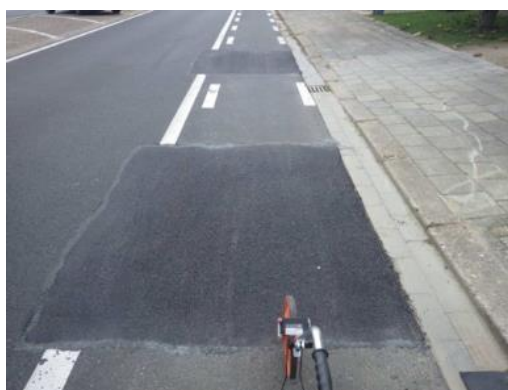
Figuur 5-8 Lokale herstellingen in het fietspad in het proefvak Decipave [B. Duerinckx – 15]
