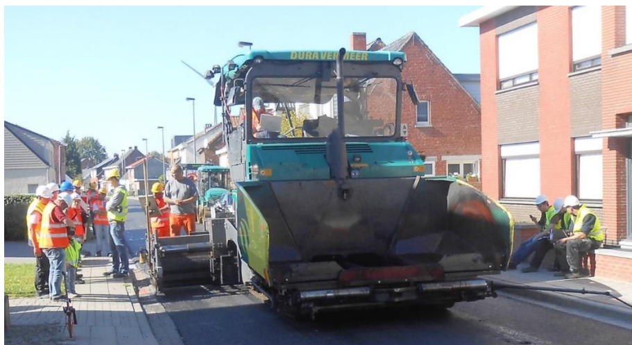
Figuur 4-1 Aanleg van het proefvak Micropave in Zandvliet door Dura Vermeer BV [C. Vuye]
