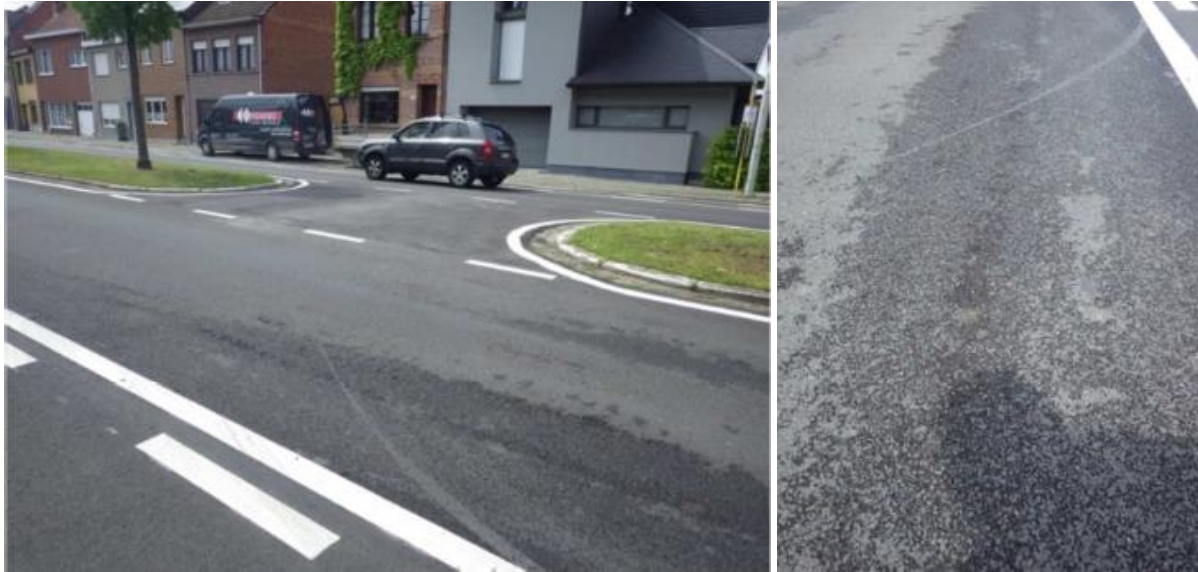
Figuur 5-2 Rafeling op het proefvak Rugosoft [B. Duerinckx – 15]
