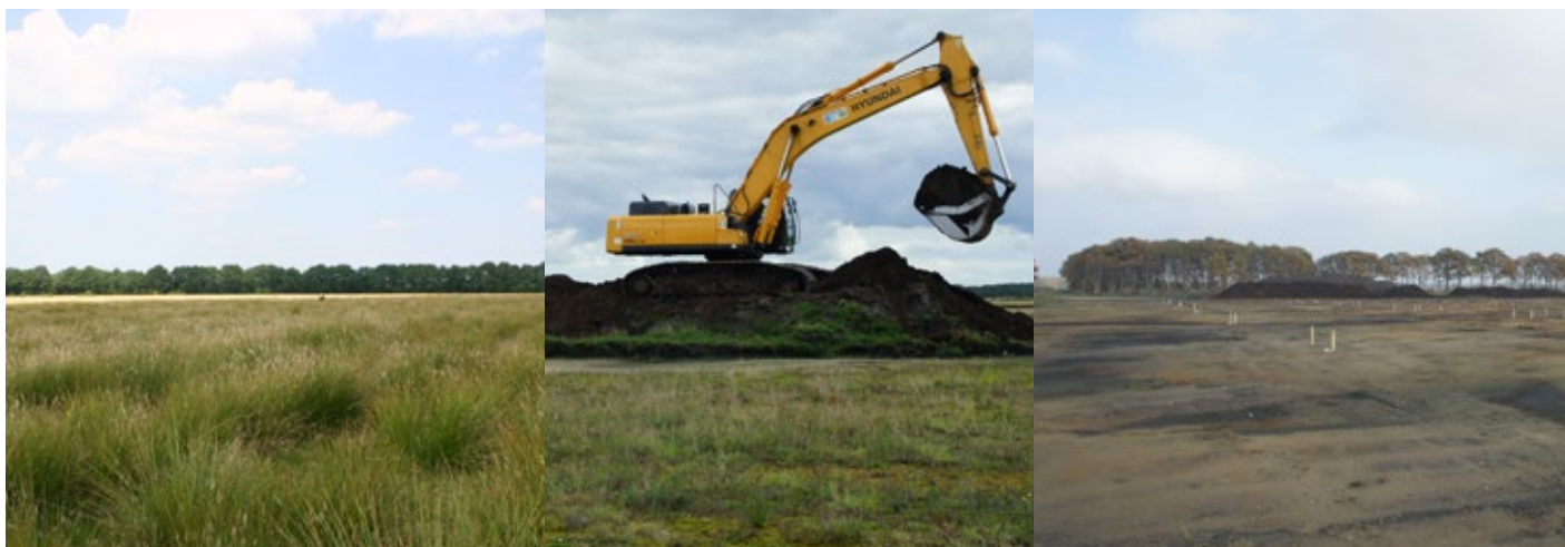
Figuur 3.1. Proefvelden voor ontgronden in 2008 (links), graafmachine tijdens het afgraven van het Noordenveld (midden) en rechts het inzetten van de proefvelden in oktober 2011. Het restant van de bouwvoor is nog goed te zien (donkere plekken).
