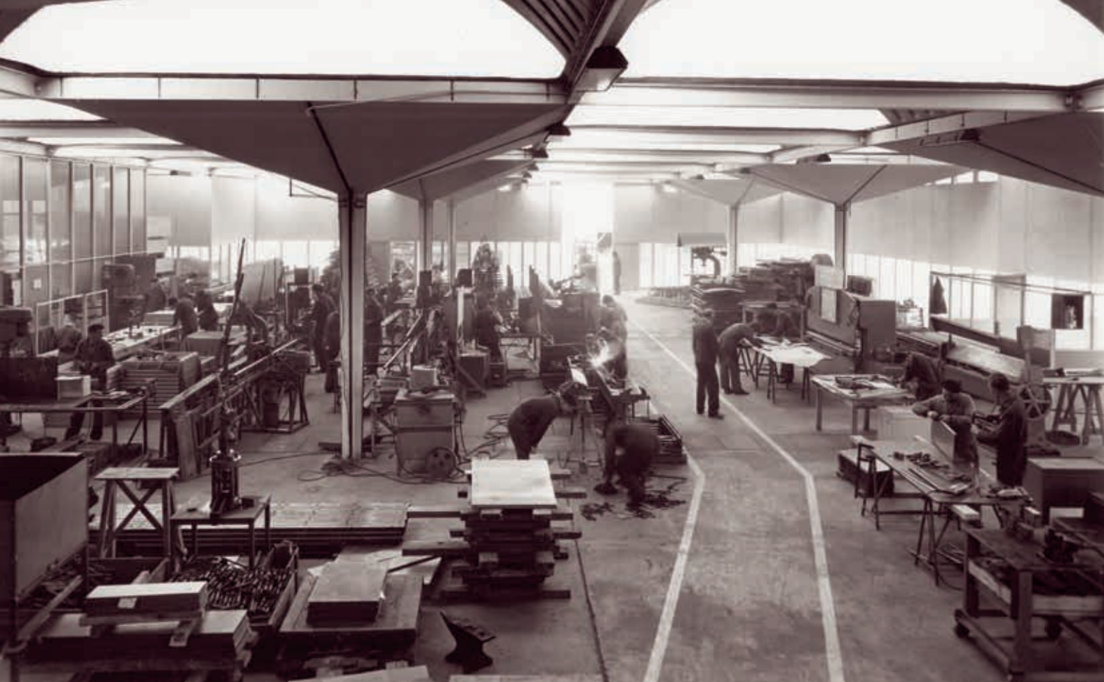
3. De metaalafdeling in de IPAN-werkplaats in Oostende met links de verfspuitcabine in verplaatsbare wanden. Foto Roland, ca. 1969 (Vlaams Architectuurinstituut)
