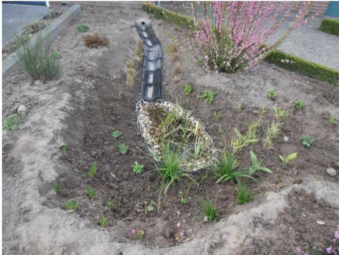
Figuur 13: voorbeeld van een kleinschalige infiltratievoorziening in een voortuintje © foto Giel Van Eck
