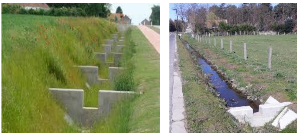
Figuur 17: Voorbeelden van baangrachten gecompartmenteerd door middel van betonnen stuwen met overloopprofiel. Rechts is duidelijk zichtbaar dat het effect op licht hellende grachten groot kan zijn. Dergelijke stuwen zijn te verkiezen boven knijpconstructies met een opening onderaan. © Staes Jan
